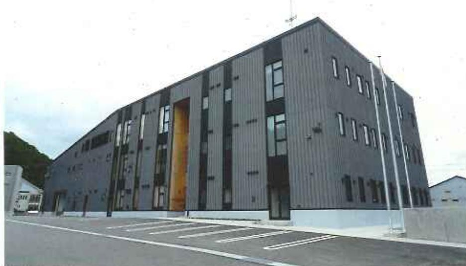
川上と川下が協定を結び地域材を最大限利用する供給体制が構築されており、使用木材はすべて地域材。CLT、WOODALC120、縦ログなど多様な木質部材を現しで使用することで木質感を創出。消防庁舎という特殊用途での木質空間は安らぎと柔らかな質感を与え、職員の心身面への効果も期待される地域のシンボル的な施設となっている。鉄骨造の床構造をデッキコンクリート床からCLT床に置き換えることにより固定荷重の軽減が図られ、鉄骨総重量の縮減と基礎設計用軸力の軽減によるコストダウンを可能としている。
