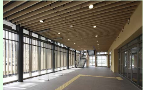
静岡地方方法務局藤枝出張所（天井ルーバー）
