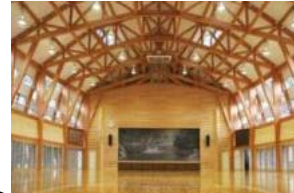
山梨県 小菅村体育館
