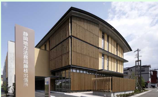
静岡地方方法務局藤枝出張所 (外壁)
