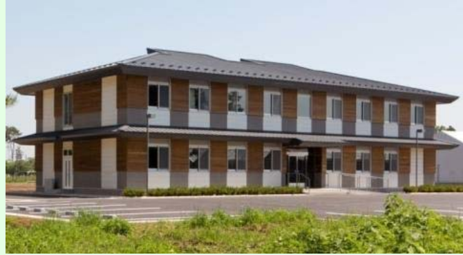
横浜植物防疫所つくばほ場 事務・検査棟
