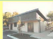
平塚地方合同庁舎 会議室棟(木造化)
