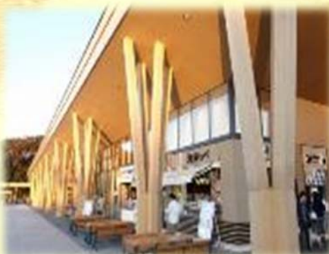
東日本高速道路(株)：守谷サービスエリア
