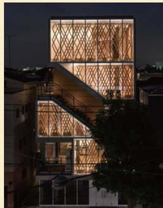
被覆型耐火と木材現し筋違による 5階建て耐火共同住宅 【東京都世田谷区 (RC造1層、木造4層)】
