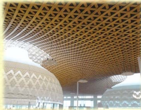
岐阜県岐阜市：ぎふメディアコスモス
