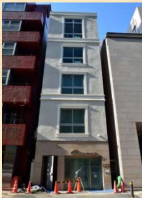
枠組壁工法による 5階建て耐火店舗付共同住宅 【東京都中央区 (RC造1層、木造4層)】
