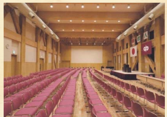
耐火集成材による大規模ホール 【山形県南陽市(木造3層)】
