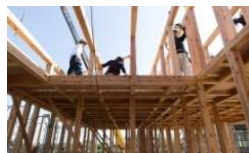
【木造住宅の建築状況】
