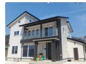
【完成した木造軸組住宅】
