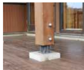
柱脚部の金物設置例
