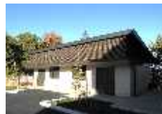
平塚地方合同庁舎 会議室棟(木造化)
