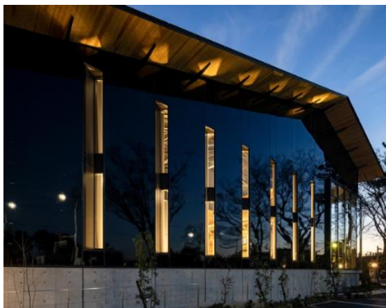
〈オフセットサイディング 施工事例〉
