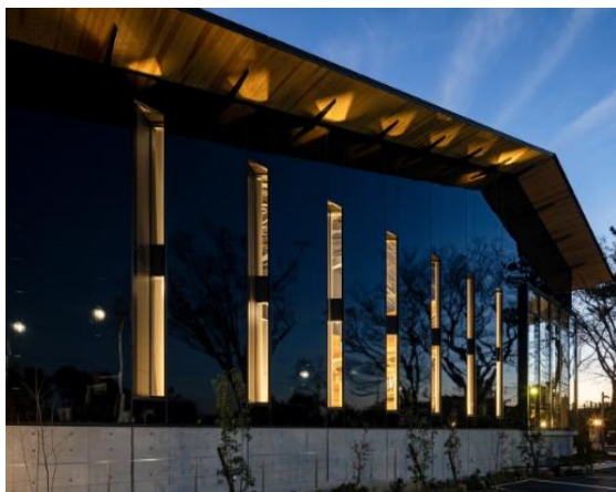
〈オフセットサイディング 施工事例〉
