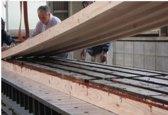
④ 燃え代層の取り付け
