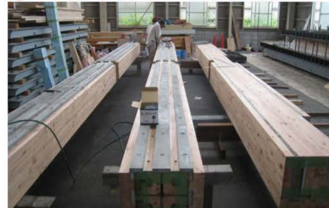
③ モルタルバーの取り付け
