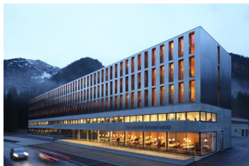
小規模工務店が施工した木造ホテル（同ホテルHPより）
