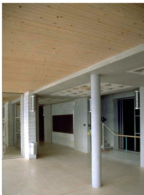
RC 骨組に木造床を組み合わせ軽量化を図ったリヒテンシュタインの小学校
